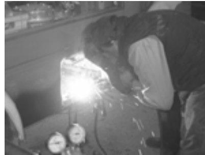
Schweißarbeiten am Batteriefach
